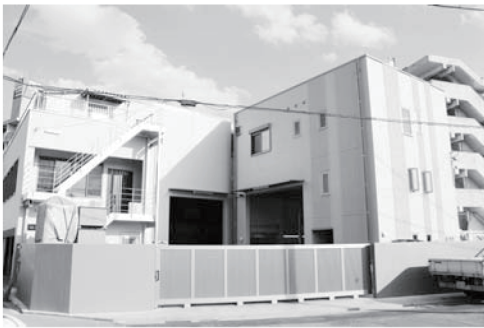
大規模改修を施した本社工場
